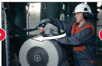
Enrosque el sistema de lubricación en el punto de lubricación
